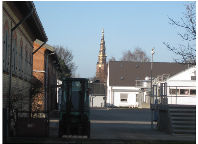
De gamle kasernebygninger til venstre.
